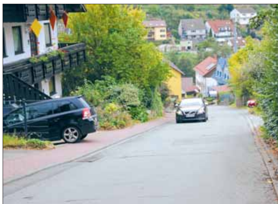
Zu steil: Im Lindengrund wird es vorerst doch keine neue Asphaltdecke geben. Foto: Fink
